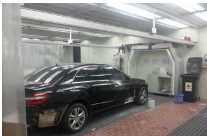
Installazione in area di preparazione.
